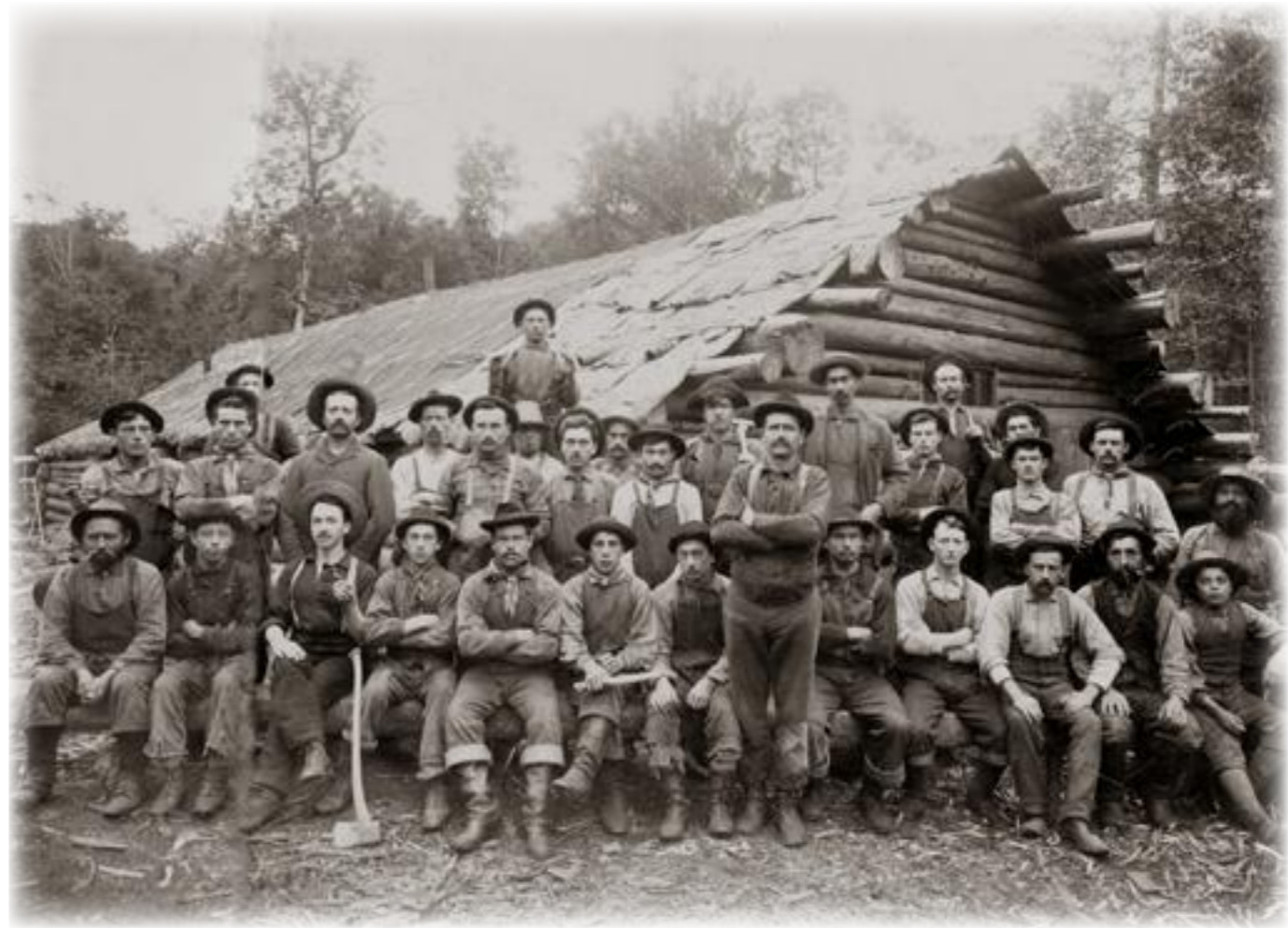
Les camarades de chantier.
